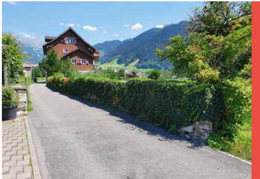
Grenzgasse vor der Sanierung: Die Mörtelmauer ist dicht mit Efeu bewachsen. Im Kronenbereich fehlt der Mörtel.
